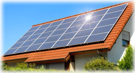
Sur toiture, source : engie-travaux
